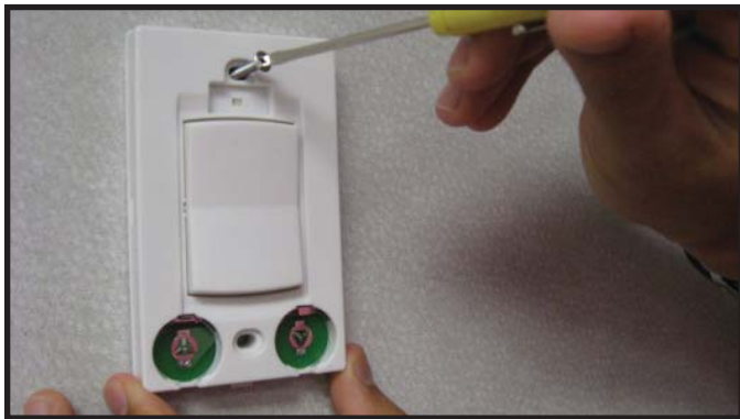
Figur 2 Montere trådløs veggbryter
